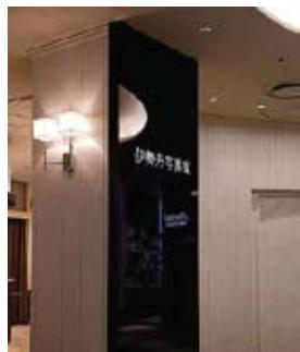
スーパーブラックを施したステンレスをデパートの屋内案内板に使用しています。鏡面仕上げのスーパーブラックがもつ重厚さと高級感がデパートのイメージにマッチしています。パネルは曲げ加工、溶接、仕上げ加工後の着色ですが、むらなく均一な発色となっています。
